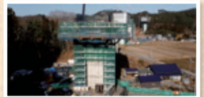
終点側より(仮)夏井高架橋を望む
