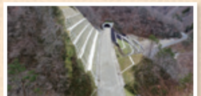
(仮)柏木平第二トンネル上部より起点側((仮)柏木平第一トンネル)を望む
