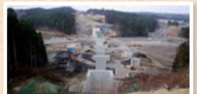
起点側より(仮)野田ICを望む
