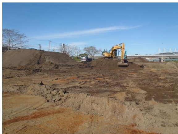
久慈川の河道掘削状況
