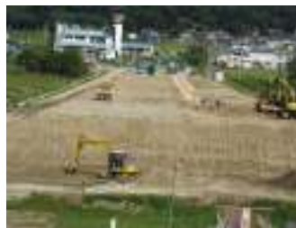
【野田山形線野田地区道路整備工事】
