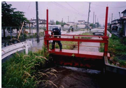
大雨時の水門(ゲート)の開閉操作 (管理人が不足し、維持管理能力が低下)
