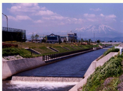
幹線水路(盛岡市)
