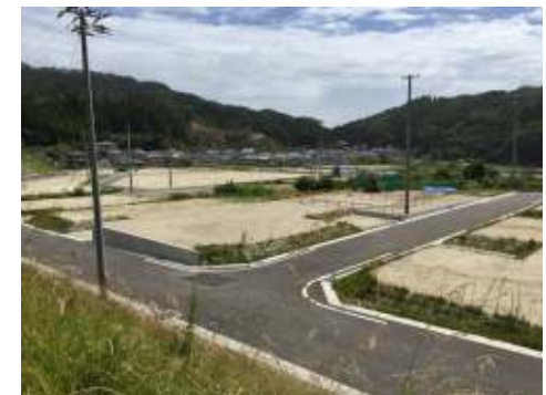
山田町「船越・田の浜」地区 (平成28年8月撮影) 防災集団移転促進事業による移転先宅地の整備状況
