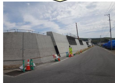
【施工状況 (既設防潮堤を約1m嵩上げ)】
