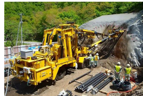
一般国道281号案内工区(トンネル掘削)
