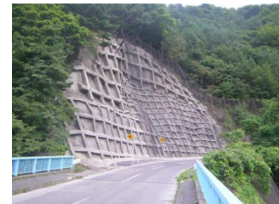
主要地方道岩泉平井賀線 (黒崎～明神地区)
