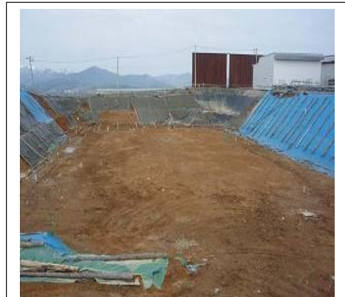
図 1: キャッピングシートを外した N 地区現況写真 (H25.5.13 撮影)
