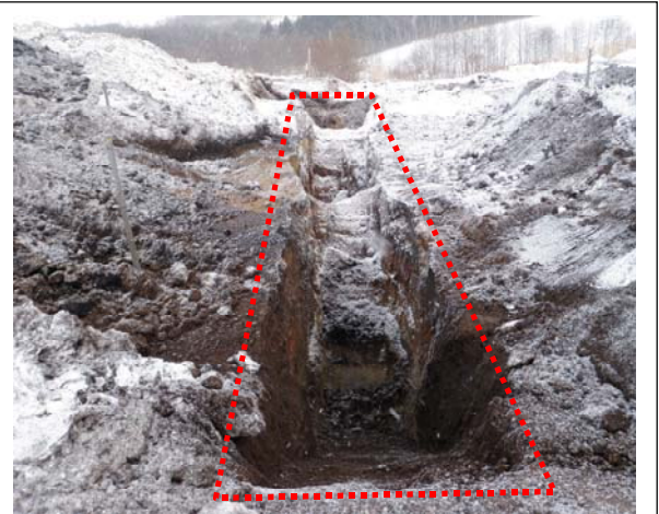
図 1：O 地区埋設想定エリア周辺試掘状況（赤破線内にゴミ有）
