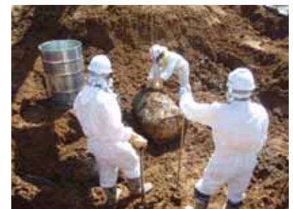
ドラム缶撤去作業
