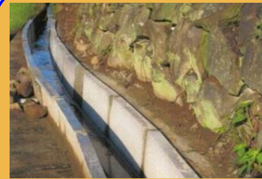
土水路からコンクリート水路への更新
