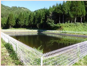
(交付金を活用して整備した貯水池) 久慈市・滝第2集落協定
