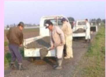
農道の路面補修
