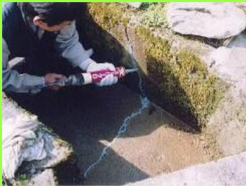
水路のひび割れ補修
