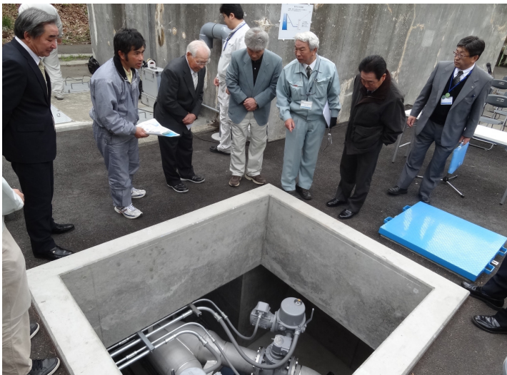
施設見学(発電機を覗き込み発電の仕組みに聞き入る出席者)
