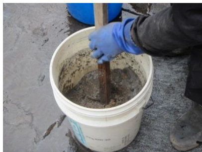
② お湯をいれ、かき混ぜる。かき混ぜる時間はお湯の温度により変わる。お湯の温度が50度のときは30秒程度、70度以上のときは5秒程度かき混ぜる。
