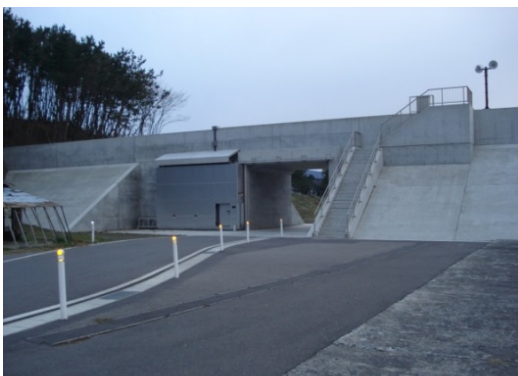
りっこう陸閘 道路として開放している部分で あり、津波時には扉を閉める
