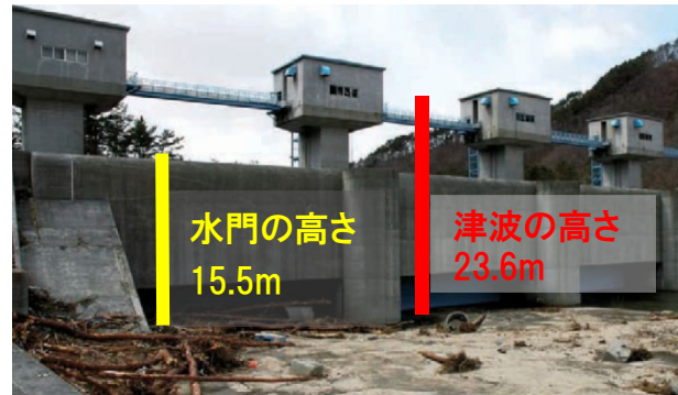
普代水門（昭和 59 年建設）
