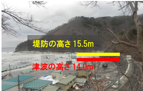
太田名部防潮堤（昭和 42 年建設）
