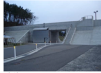
陸閘 道路として開放している部分であり、津波時には扉を閉める
