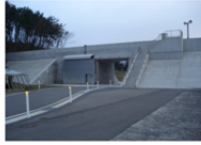
陸開 道路として開放している部分であり、津波時には扉を開ける
