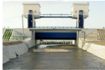
水門 門を閉めることで津波が川に沿って浸入するを防ぐ
