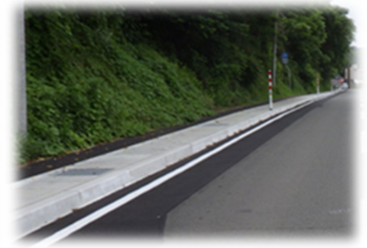
歩道の設置（例）
