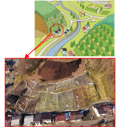
がけ崩れ対策施設（例）
