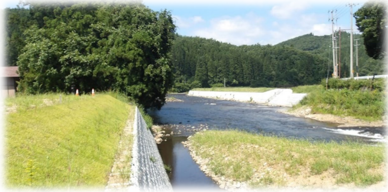
河川の改修（例）
