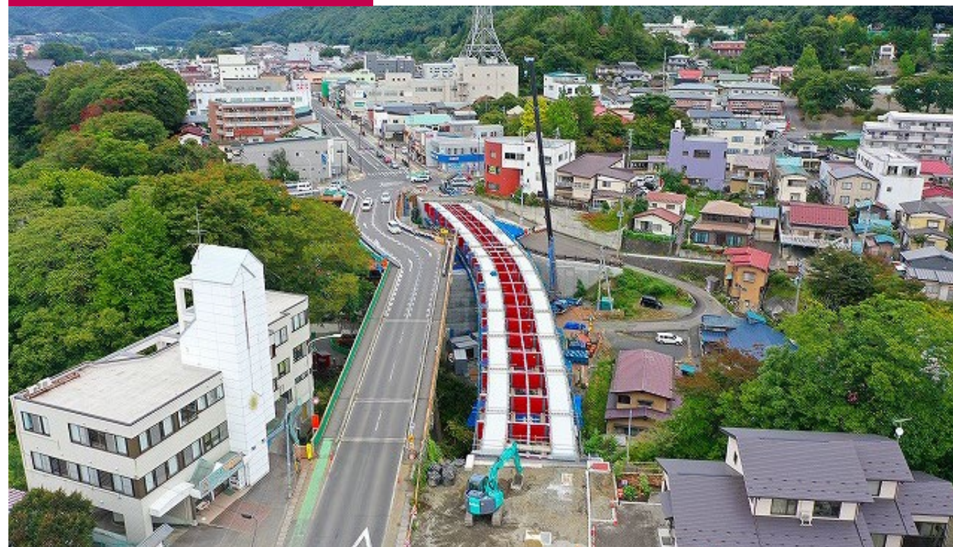
② 橋桁の設置【1期施工】 (2020. 9)
