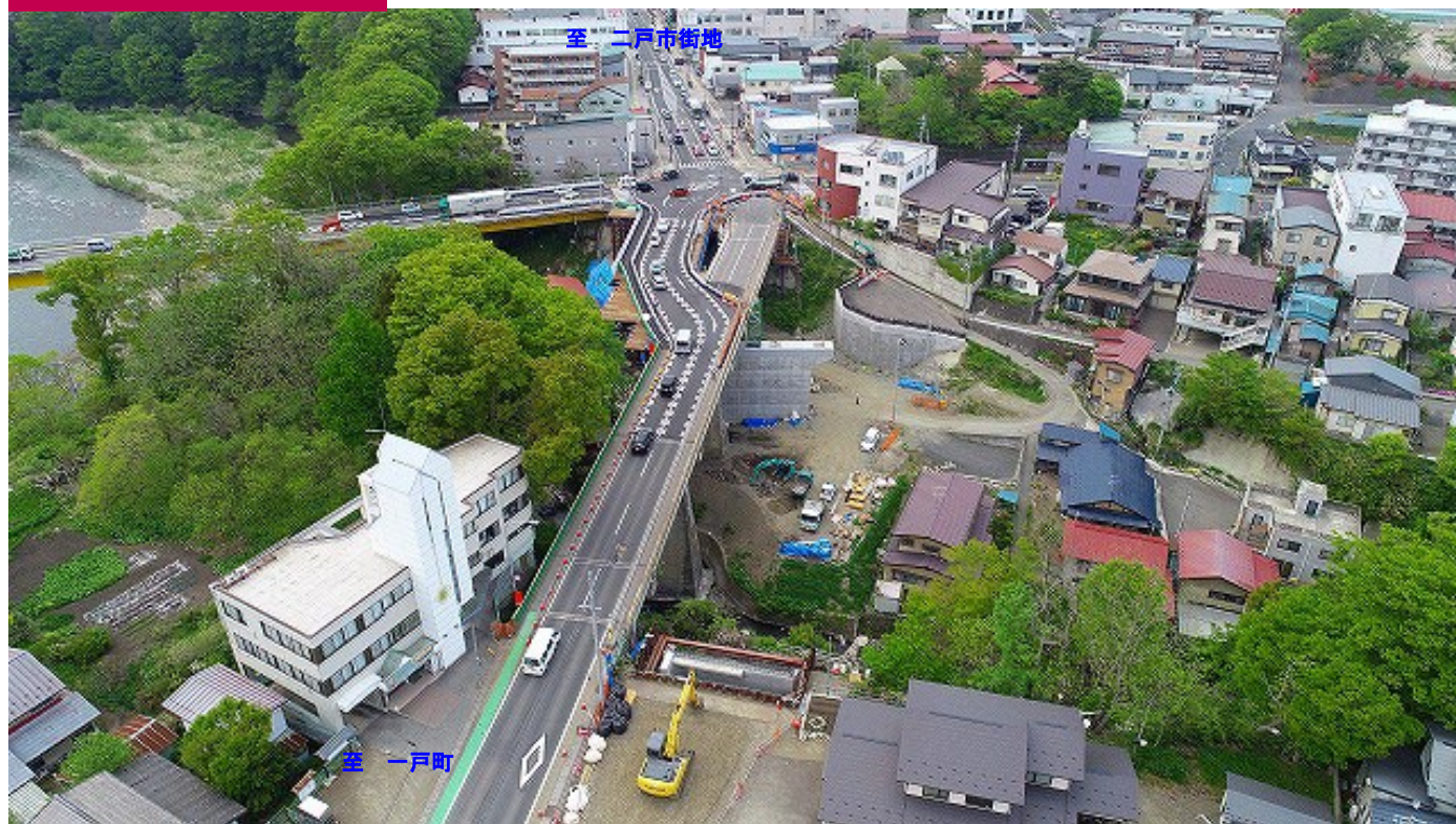
① 仮橋の設置 (2018. 5)
