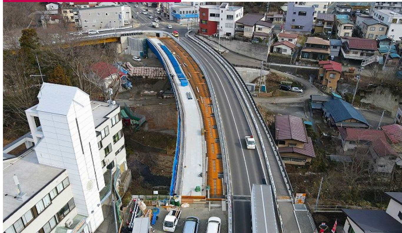
④ 完成形 (施工中) 【2期施工】 (2023. 3)
