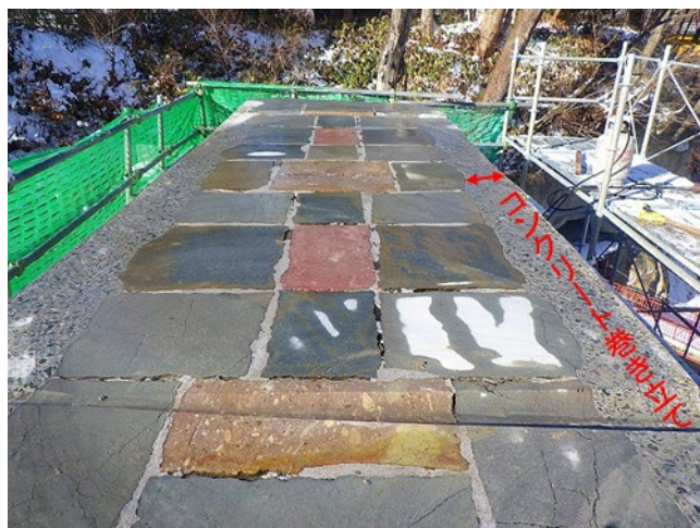
[橋脚上部カット後の状況]
