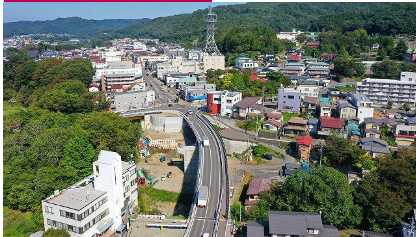
③ 旧橋と仮橋の撤去、橋台・橋脚の設置 (2022. 9)
