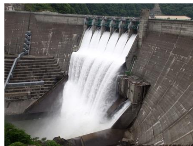
湯田ダムのクレストゲートの試験放流の写真
