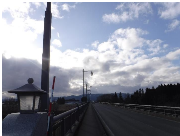
紫波町公共施設照明灯LED改修工事（紫波町）
