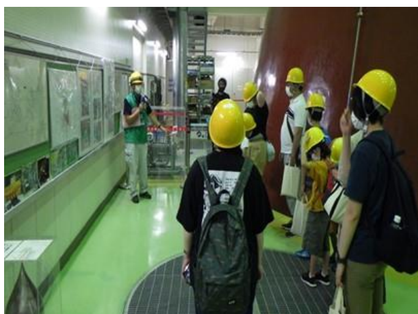
岩洞第一発電所の見学
