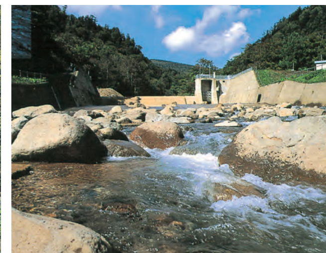
北ノ又川第二取水堰堤
