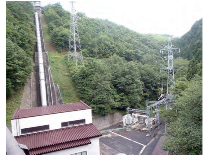
岩洞第二発電所
