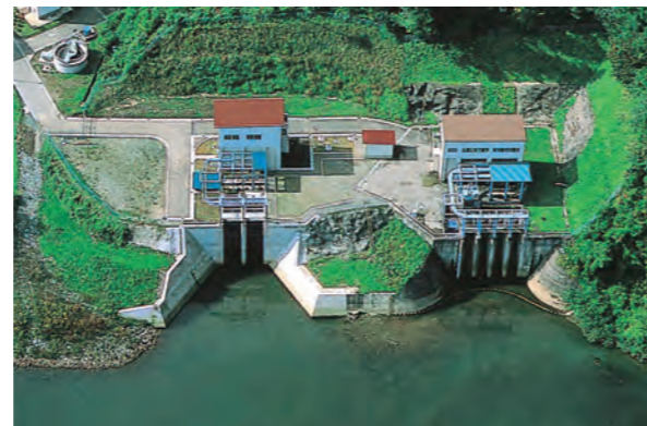
■ 第三浄水場 (旧第三工水) 取水口 (写真左) ■ 第一浄水場 (旧北上工水) 取水口 (写真右)
