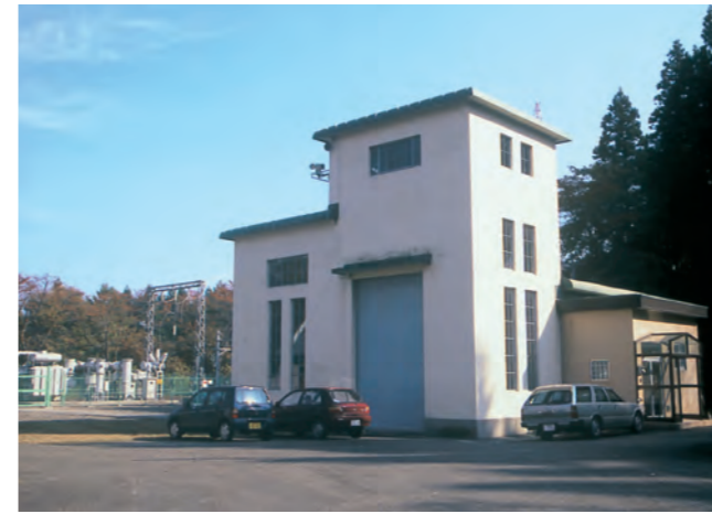
胆沢第二発電所
