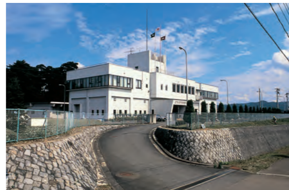
第一浄水場 (旧北上工水) 管理棟
