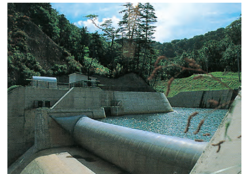
松川取水堰・ゴム引布製起伏堰
