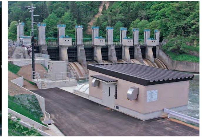
胆沢第四発電所と若柳堰堤
