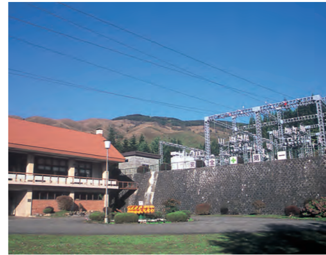
岩洞第一発電所
