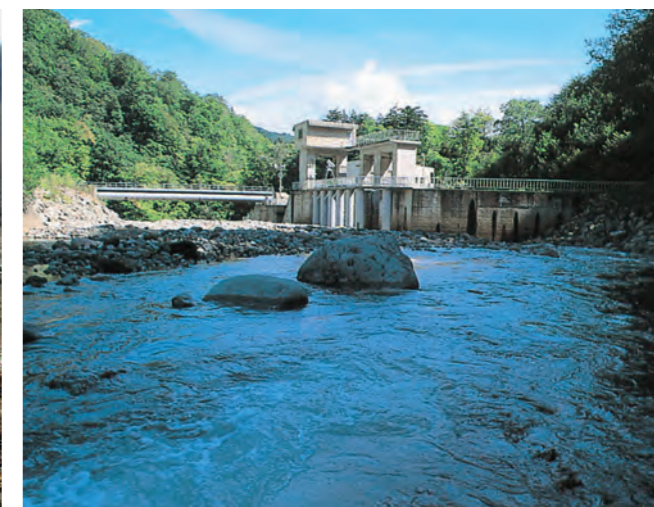
北ノ又川取水堰堤
