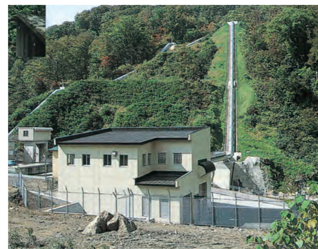
北ノ又第二発電所
