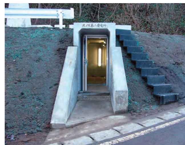
北ノ又第三発電所（入口）
