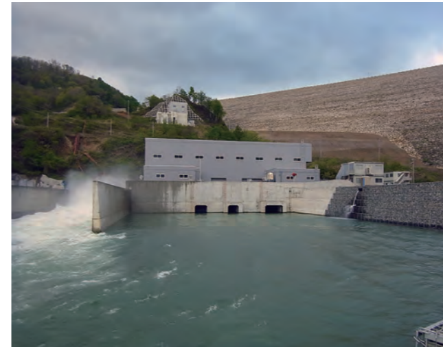
胆沢第三発電所
