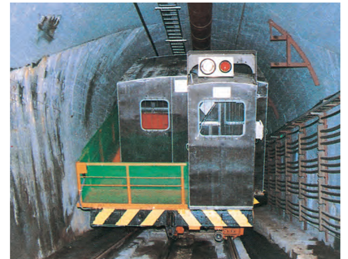
インクライン（地下発電所と地上を結ぶケーブルカー）
