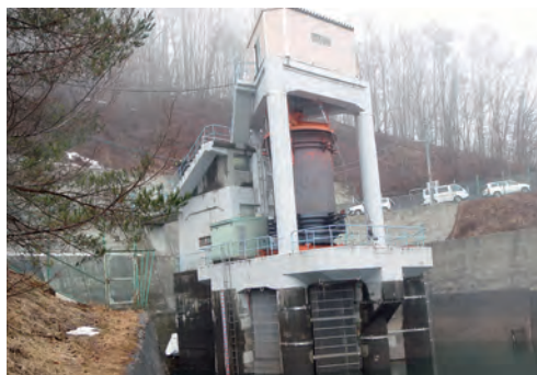
【写真】岩洞取水口
