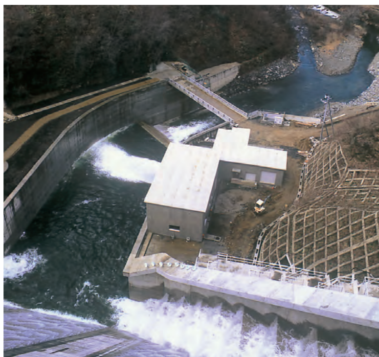
早池峰発電所
