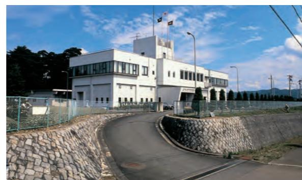
第一浄水場 (旧北上工水) 管理棟
