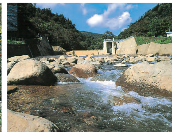
北ノ又川第二取水堰堤
