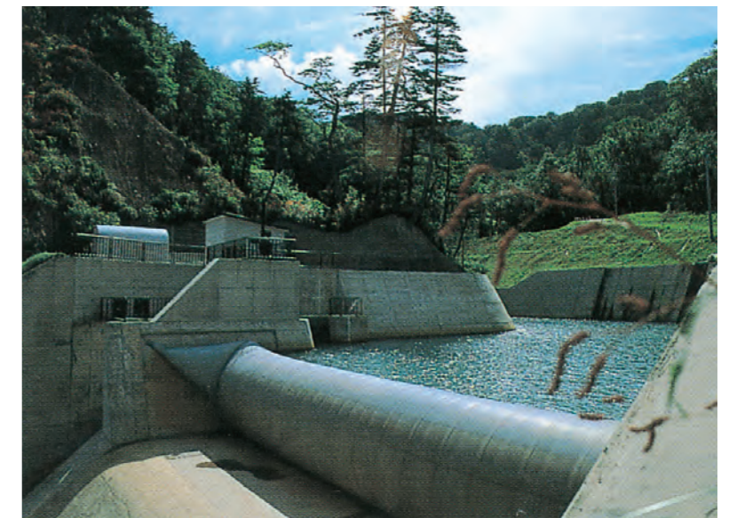
松川取水堰・ゴム引布製起伏堰
