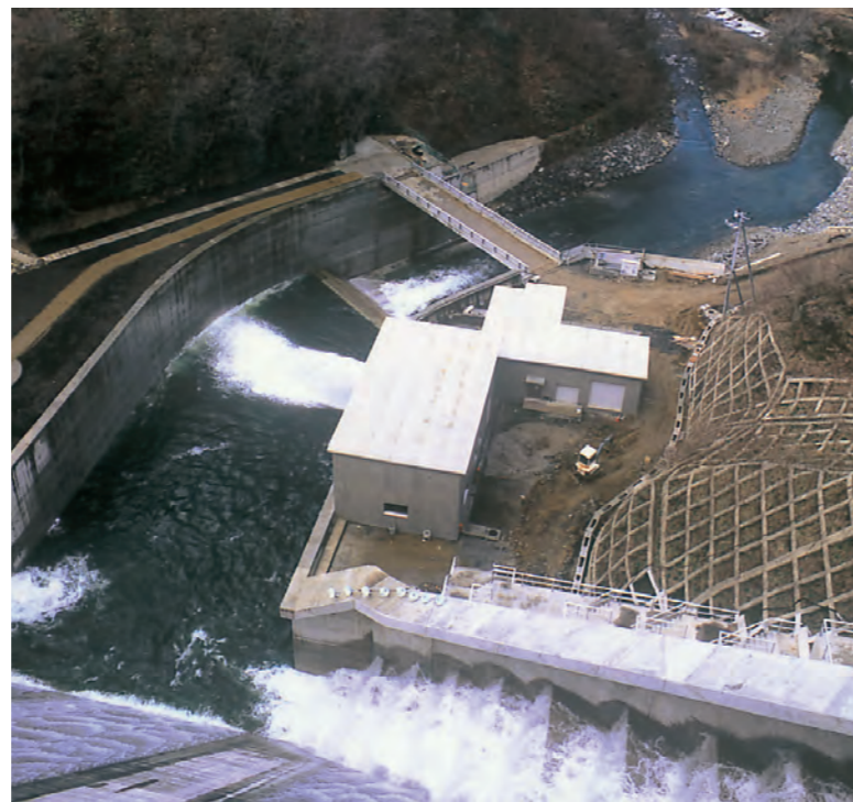
早池峰発電所
