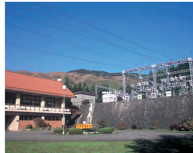
岩洞第一発電所
