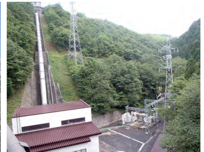
岩洞第二発電所
