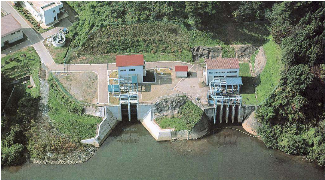
↑ 第一北上中部工業用水道の取水口。北上川から取水し、不純物を取り除くなどの処理を行ってから、北上工業団地に供給しています。
