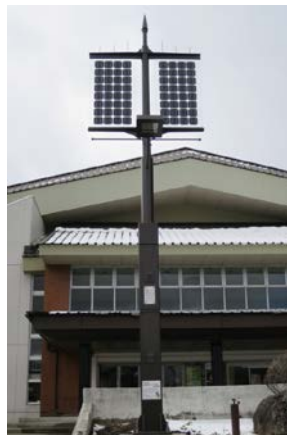
洋野町国保種市病院駐→ 車場ソーラー照明灯整 備事業 (H26)
