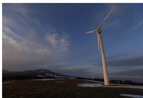
稲庭高原風力発電所 (1,980kW、H13.9 運転開始)
