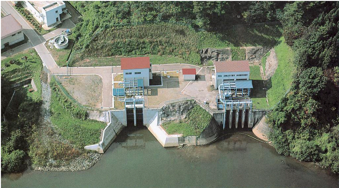
↑ 第一北上中部工業用水道の取水口。北上川から取水し、不純物を取り除くなどの処理を行ってから、北上工業団地に供給しています。
