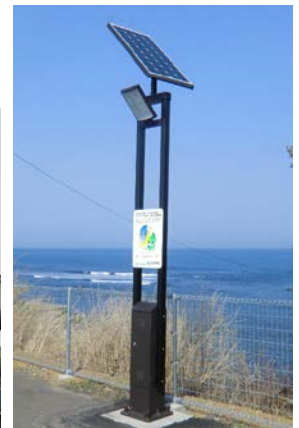
←葛巻町社会体育会独立防 災型ソーラー街路灯導入 事業 (H26)
