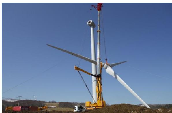
風車の羽根を地上で3枚組み合わせたものを、ナセルに据え付けます。
