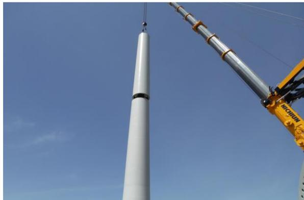
タワーは4つに分割されているので、すでに据え付けたタワーの上に積み重ねていきます。
