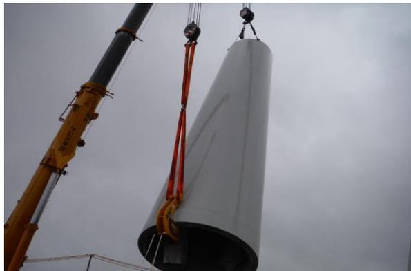
タワーは大型のクレーンによって吊り上げられ、基礎と接合されます。
