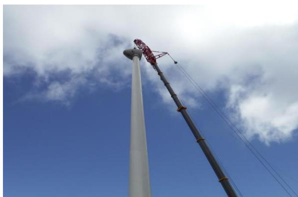
タワーの最上部の上には、たくさんの機械が入ったナセルという部分を据え付けます。
