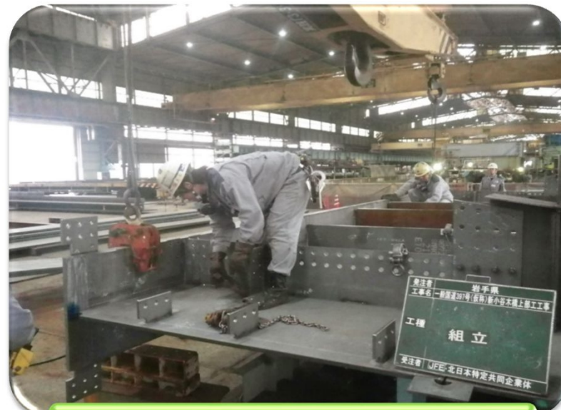
【組立作業】 図面通りに部材を組立てます。
