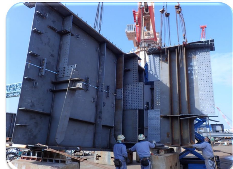
【仮組立】 工場で部材を実際に組立て、図面通り作られているか確認します。仮組立に問題が無ければ部材を分解し、塗装した後に現地に輸送します。
