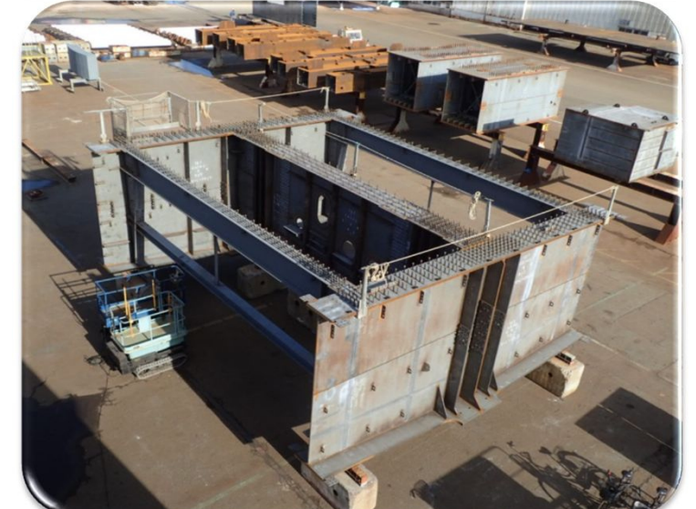
【仮組立】 工場で部材を実際に組立て、図面通り作られているか確認します。仮組立に問題が無ければ部材を分解し、塗装した後に現地に輸送します。
