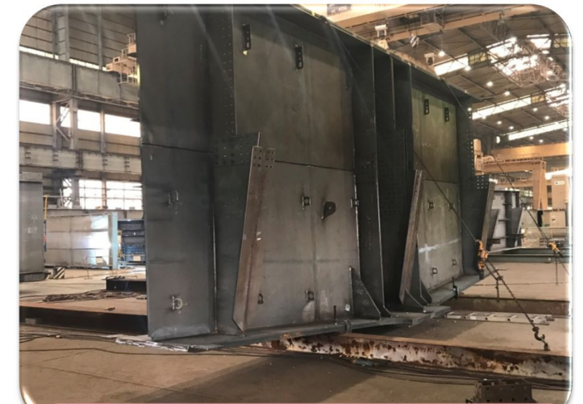
【溶接作業】 部材の溶接完了しました。
