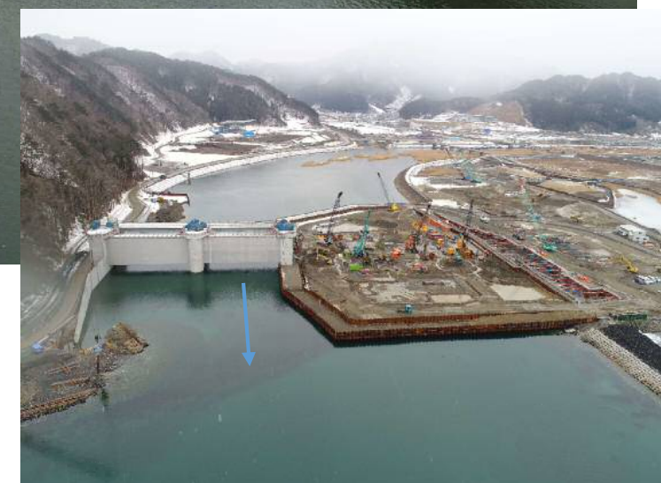
▲下流(海側)よりドローンにて撮影(H30年2月)
