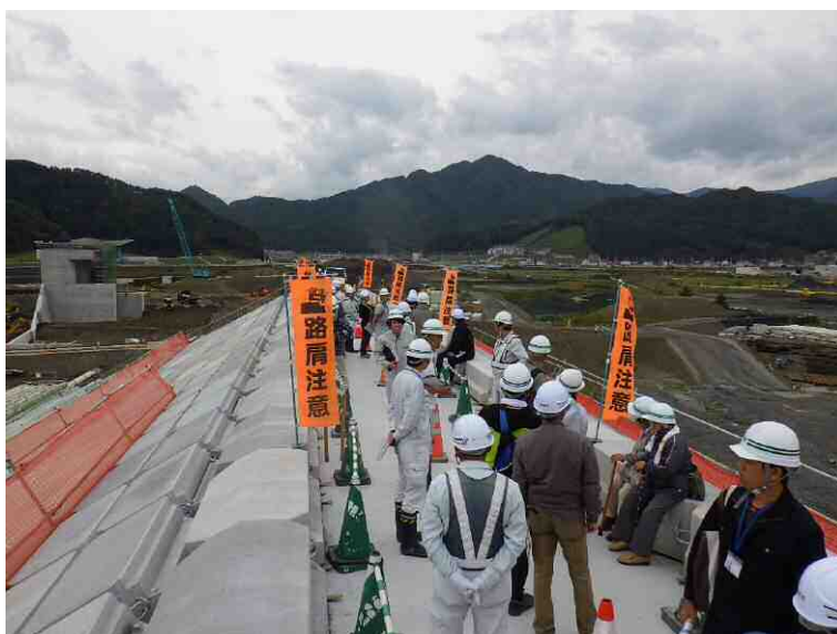
見学の様子（片岸海岸防潮堤の堤防天端部）
