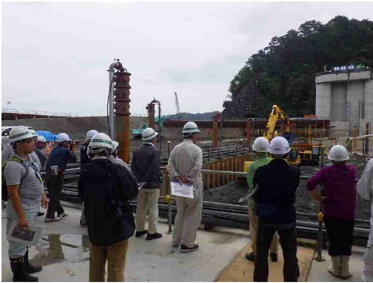
見学の様子（鵜住居川水門の堰柱等）
