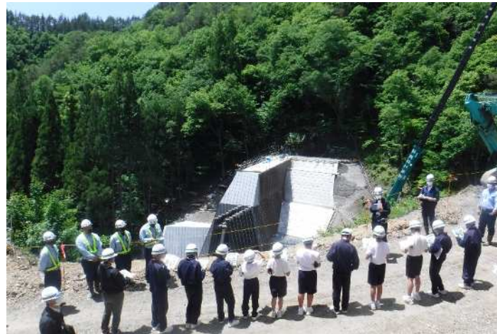
↑施工中の砂防堰堤を見学！！
