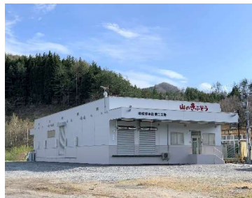
2020年 第2工場 新設
