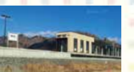
釜石鶴住居復興スタジアムの玄関口となる鶴住居駅
