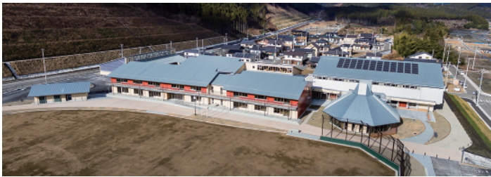
再建された「気仙小学校」（写真提供：陸前高田市）
