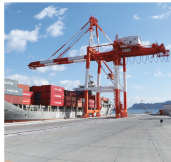
湾港機能を向上させた「ガントリークレーン」（写真提供：釜石市）
