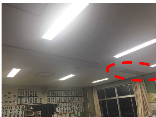
赤破線部分のモルタルが落下
