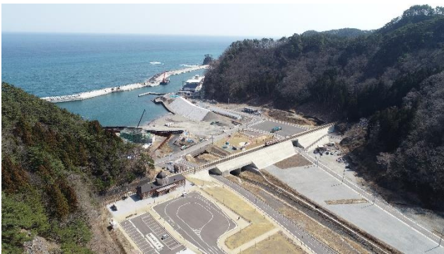
【島越地区災害復旧工事の状況】
