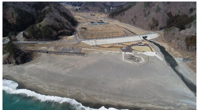
【明戸地区災害復旧工事の状況】
