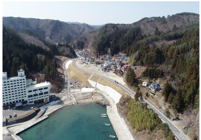
【羅賀地区災害復旧工事の状況】
