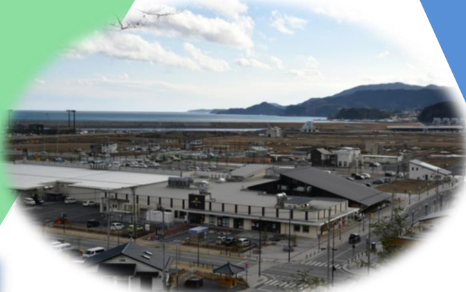
中心市街地の街並み (手前:商業・図書館複合施設 abasse TAKATA、奥:広田湾)
