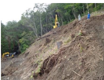
災害復旧工事現場の立会状況(桑ノ浜仮宿線)
