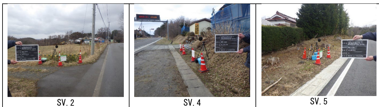
写真-1 調査地点（供用後）
