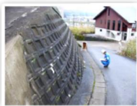
(1)被害状況確認(擁壁) 全体の被害状況を把握しながら、宅地の平面図、被害箇所の断面図を調査票に記載していきます。
