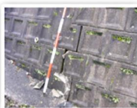
(3)被害状況の詳細調査 各被害状況の詳細(亀裂の幅、傾き状況等)を調査し、被害程度に応じて点数をつけていき、各宅地の被害程度を点数化していきます。
