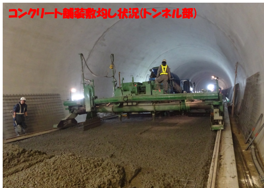
コンクリート舗装表面仕上げ状況(トンネル部)
