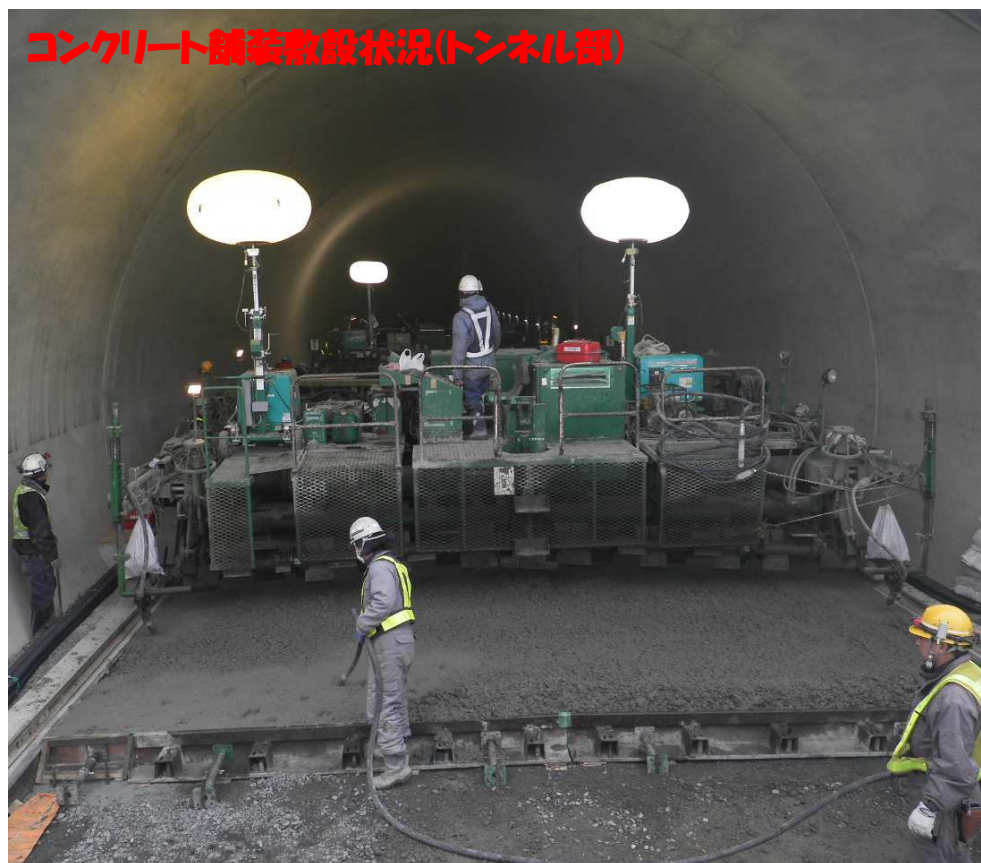
コンクリート舗装表面仕上げ状況(トンネル部)
