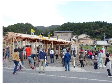
崎浜番屋「浜らいん」建築の様子
