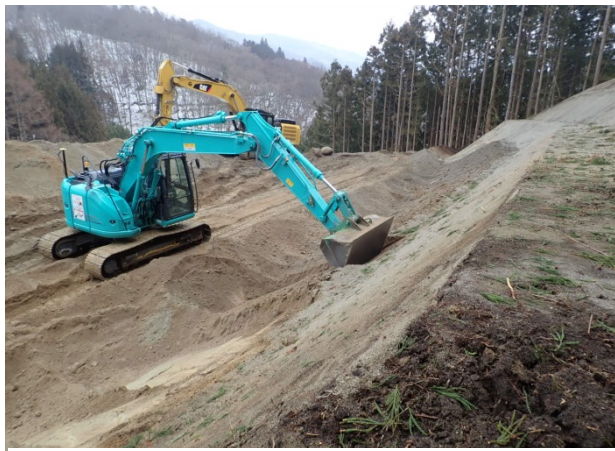
↑ 3DMCBHによる施工
