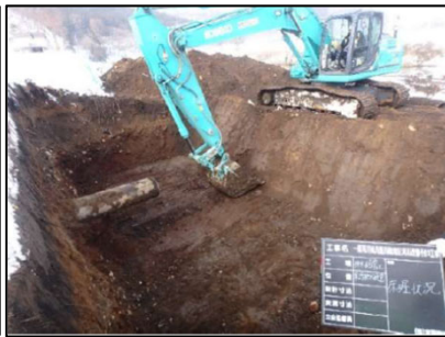
ICT建機による河川土工
