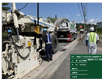
ICT施工(路面切削工)
