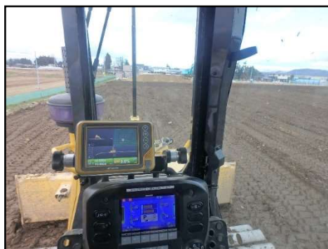
3DMCブルドーザーによる敷均し状況
