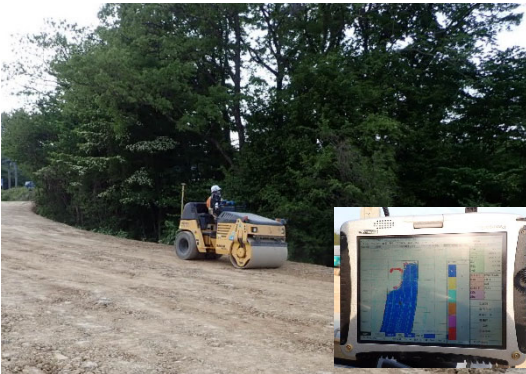
コンバインドローラーによる転圧管理
