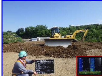
【3DMCグレーダーによる敷均し】
