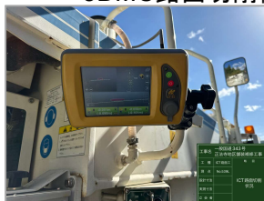
3DMC路面切削機による切削
