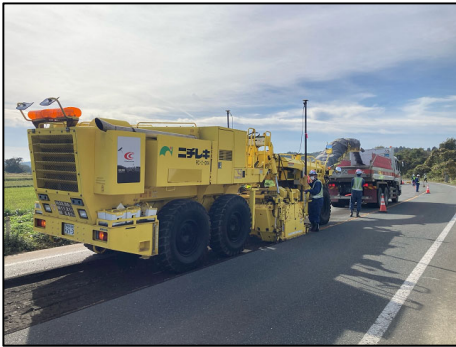
3DMC GNSS切削システムによる路面切削 3D設計データ作成、使用
