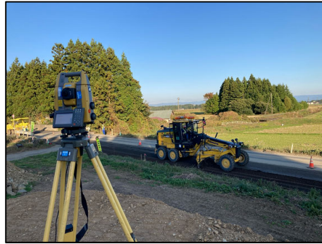
TS自動追尾MCグレーダーによる路盤整形(路上路盤再生工) 路面切削3D設計データの有効活用
