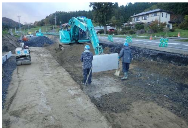
狭小箇所での重機・作業員の作業分離
