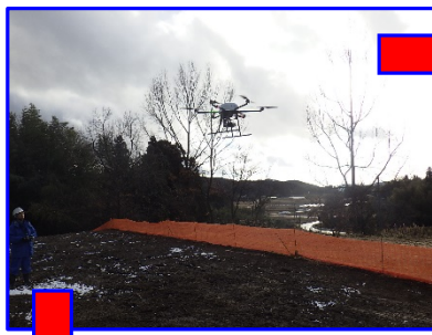
UAVIによる起工測量
