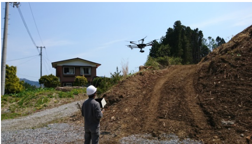
UAVIによる施工前の 空中写真測量
