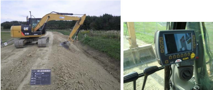
3DMGバックホウによる堤防法面整形
