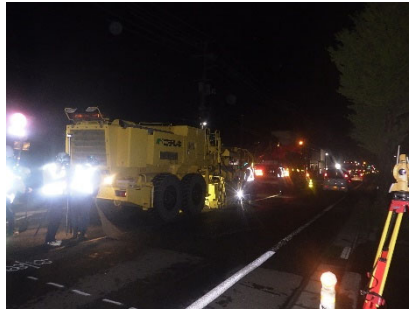
GNSS切削システム路面切削
