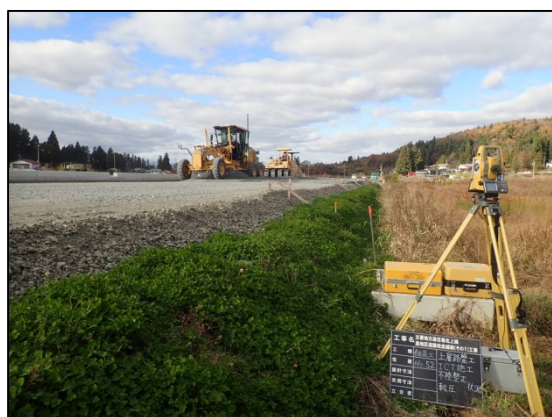
3DMCグレーダによる路盤工
