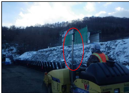
自動追尾型の転圧システムを搭載した締固め機械
