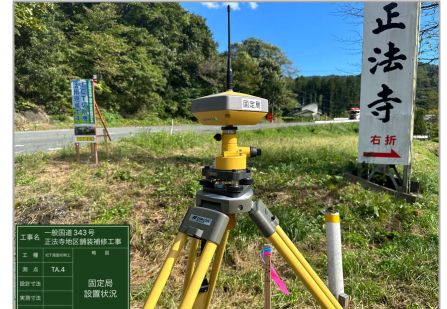
GNSS固定局設置
