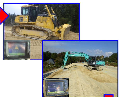
ICT建機による盛土工
