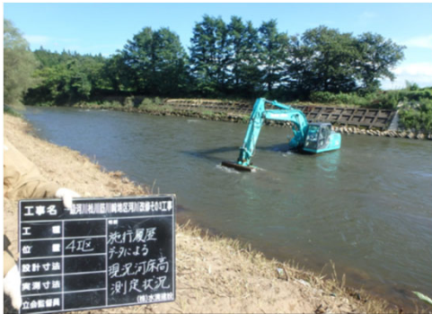
ICT建機(防水型)による河床トレース状況
