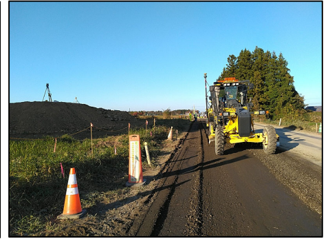
TS自動追尾MCグレーダーによる路盤整形(路上路盤再生工) 路面切削3D設計データの有効活用
