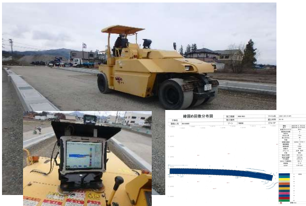
MCタイヤローラによる転圧管理
