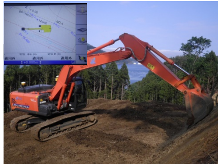
3DMGバックホウによる法面整形
