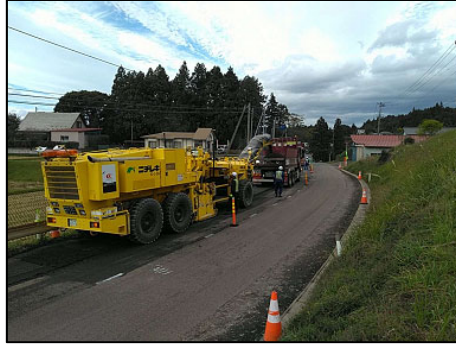
3DMCGNSS切削システムによる路面切削
