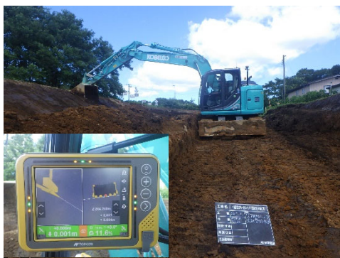
3DMGバックホウによる法面整形
