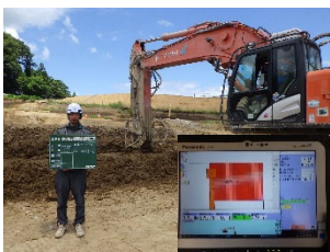
ICT地盤改良
