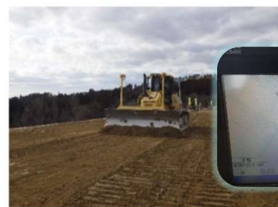
【MCブルドーザによる路体盛土の敷均し】
