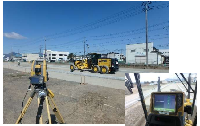
MCモーターグレーダによる敷き均し
