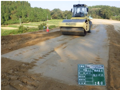
GNNSローラー締固め管理
