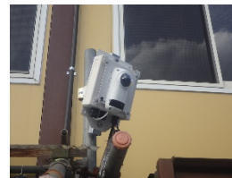
定点カメラ2台設置
