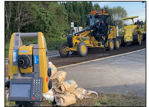
TS自動追尾MCグレーダ路上再生路盤整正 路面切削設計データの有効活用
