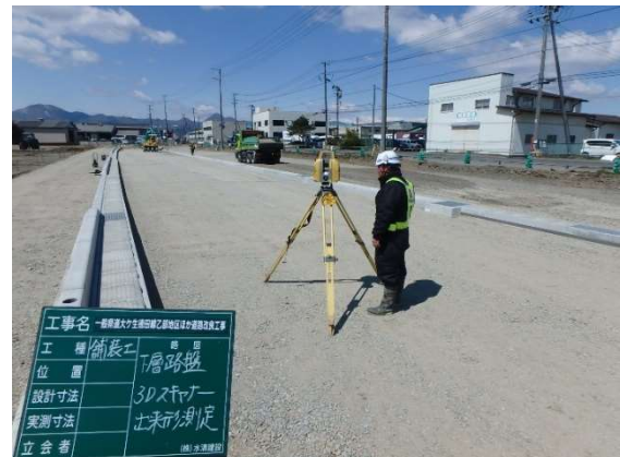
TLSによる出来形管理
