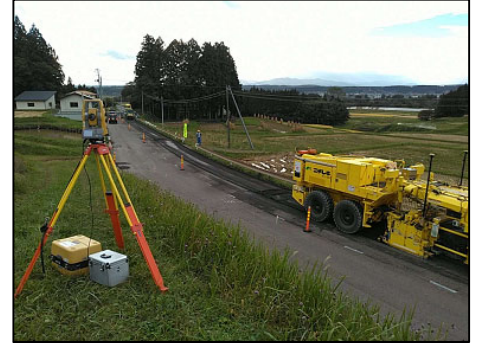
自動追尾TSによる施工精度確認
