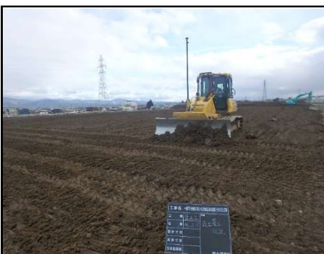
3DMCブルドーザーによる敷均し状況
