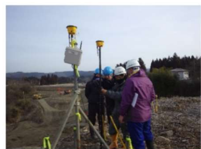
【GNSS基準局設置】
