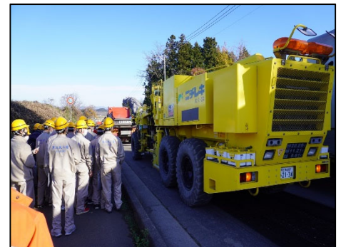
ICT施工見学会実施
