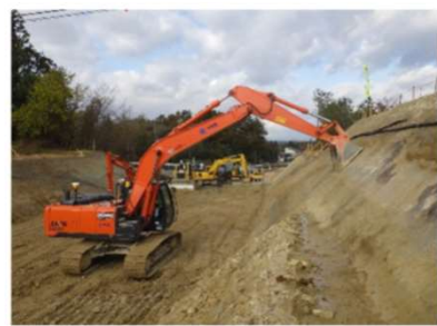
【3DMCバックホーによる切土法面整形】
