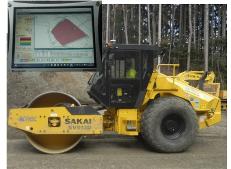
GNSS方式による締固め管理
