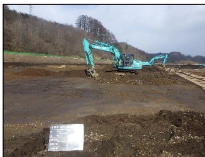
ICT建機による掘削状況
