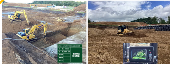
ICT土工 (MG及びMCバックホウ+MCブルドーザー)
