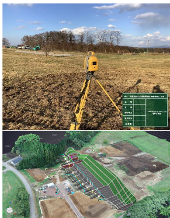
起工測量及び 3次元設計データの作成
