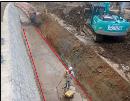
TLSによる3D出来形測量
