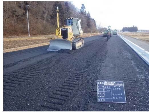
3DMCブルドーザによる路盤敷均し
