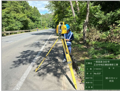
TLSによる起工測量
