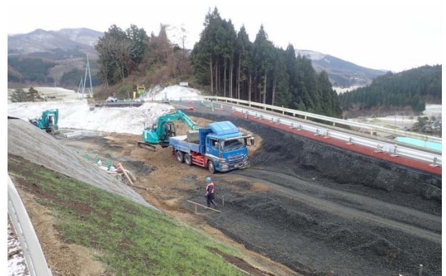
3DMGバックホウによる掘削状況
