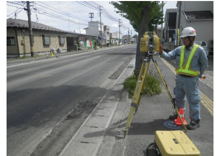
切削施工後の3次元測量
