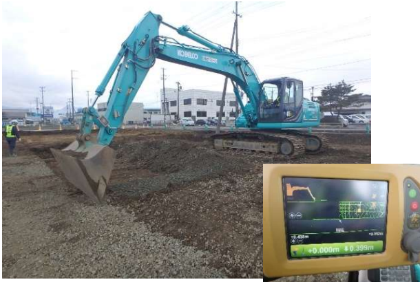
MGバックホウによる掘削
