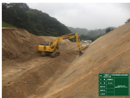
ICTバックホウによる法面整形
