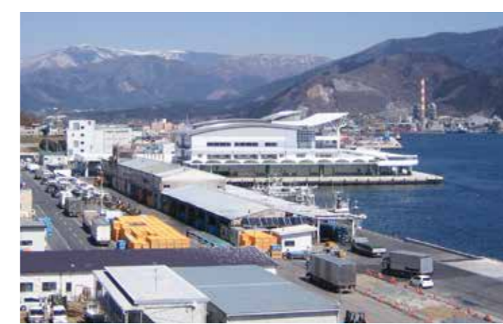
大船渡魚市場 高度衛生管理型魚市場の整備(平成26年4月完成)
