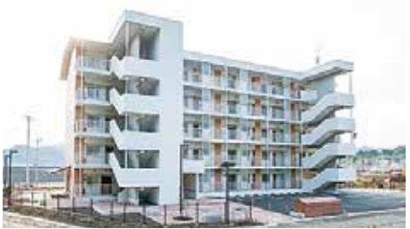
大槌町安渡地区災害公営住宅 (平成30年12月完成)
