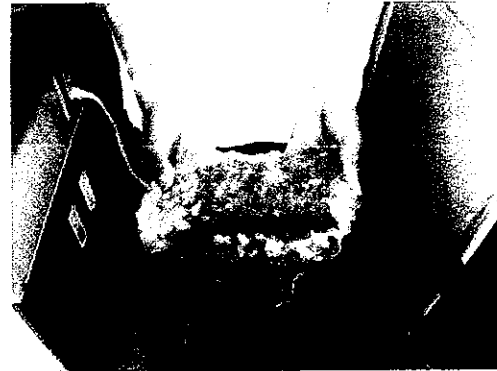
落下したコンクリート片
