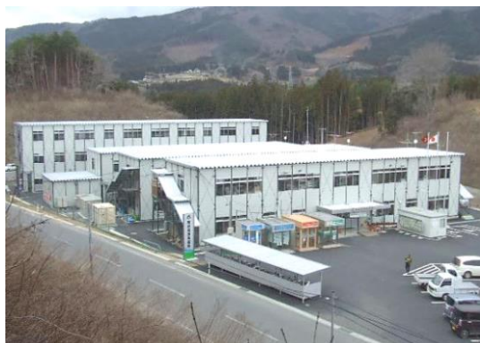
陸前高田市仮設庁舎
