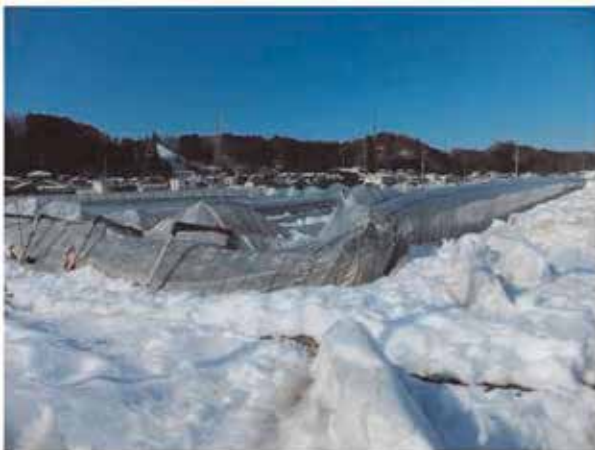
連棟パイプハウスの倒壊
