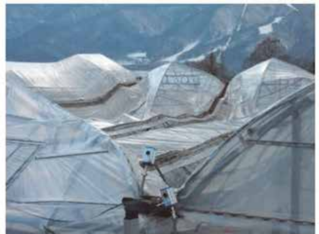
連棟パイプハウスの倒壊
