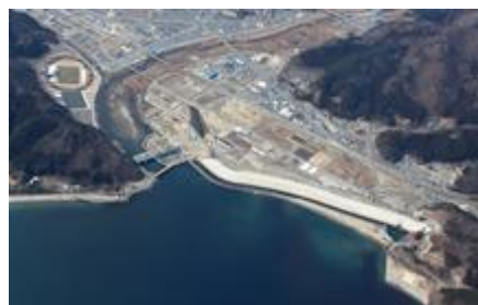
▲改正制度活用により用地取得を行った片岸海岸（釜石市）
