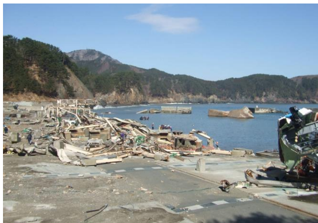
▲宮古市 音部漁港 平成 23 年震災直後
