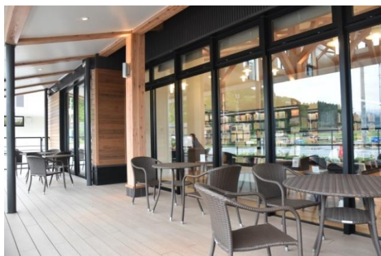
平成29年7月に開館した陸前高田市立図書館
