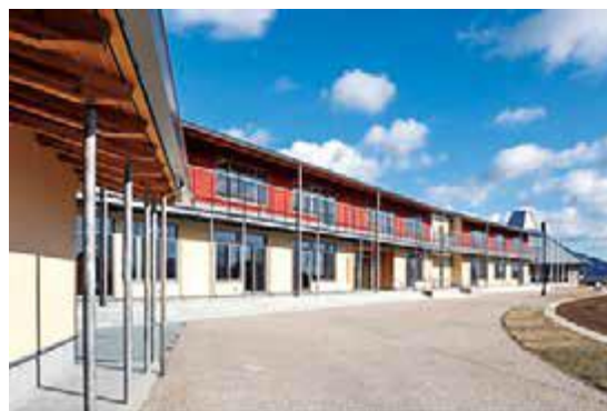
平成30年12月に再建された陸前高田市立気仙小学校
