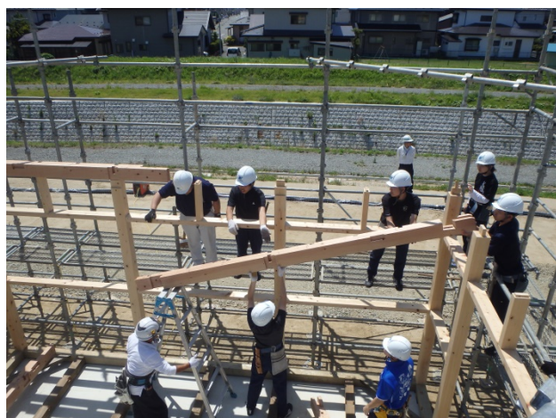
東屋の設置作業状況
