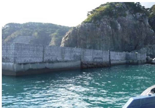
防波堤(2)のテクスチャー※は自然景観に配慮し、擬岩工法を用いた。
