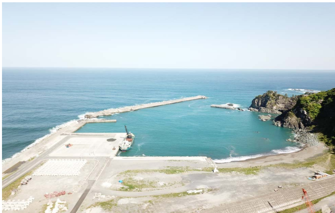
小本港の現状【港内静穏度と貨物荷役状況】 2019(令和元年)5月23日撮影
