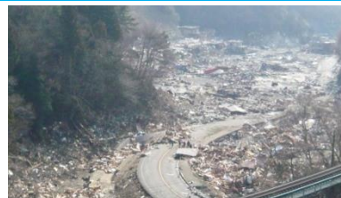
▲ガレキで覆われた国道45号
