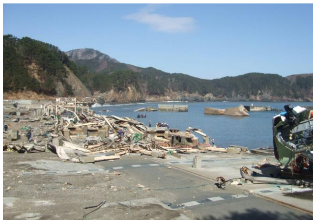
▲宮古市 音部漁港 平成 23 年震災直後
