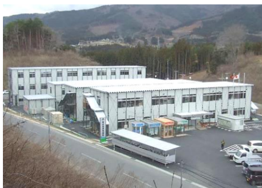
陸前高田市仮設庁舎
