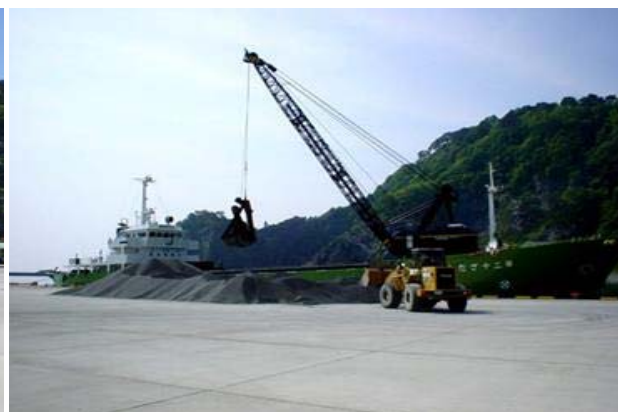
岸壁(-5.5m)からの採石の搬出状況
