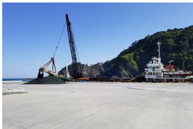
岸壁(-5.5m)からの砂の搬入状況
