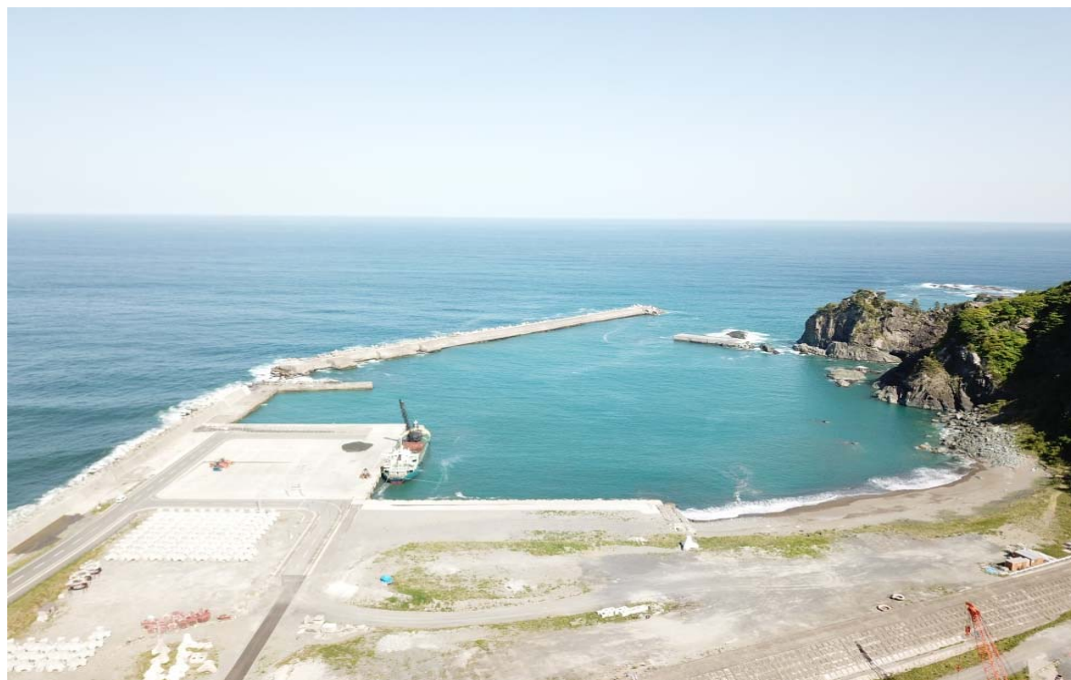
小本港の現状【港内静穏度と貨物荷役状況】 2019(令和元年)5月23日撮影
