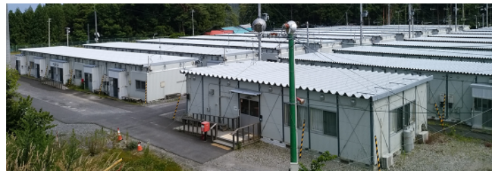
被災後、野田中学校の校庭に並ぶ応急仮設住宅（写真提供：野田村）
