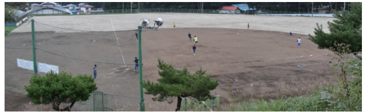
復旧工事が完了した野田中学校の校庭
