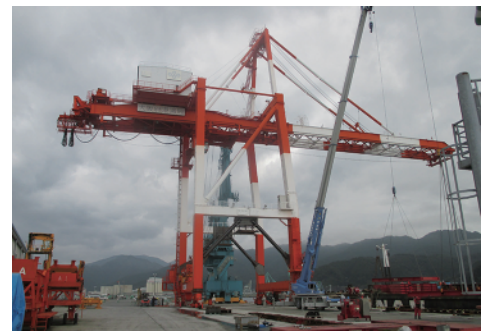
陸揚げされたガントリークレーン
